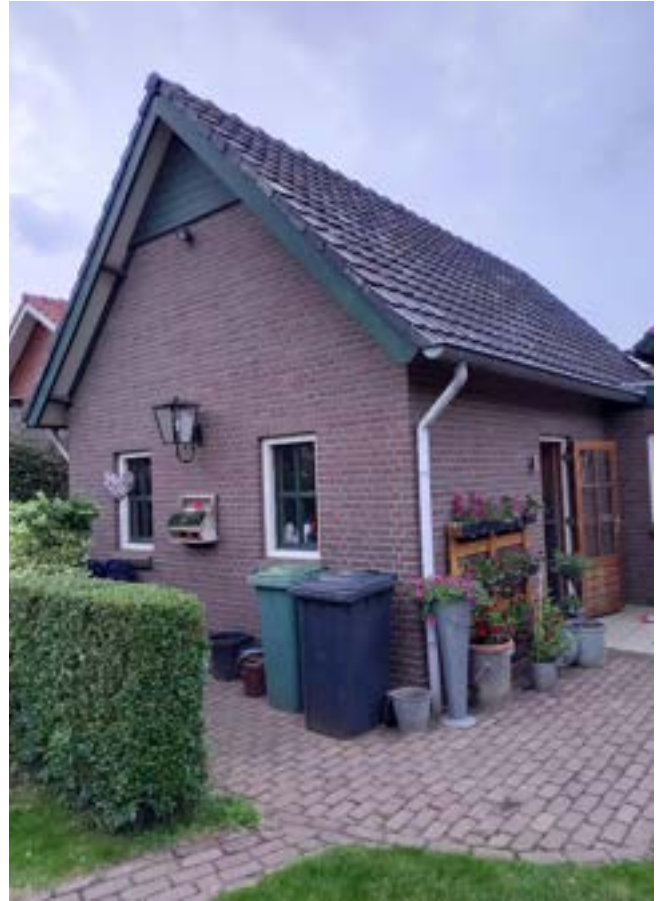
Foto 2: De eerst gevonden verblijfplaats: specifiek leek de ruimte tussen het dakbeschot en de pannen in gebruik te zijn. Foto: René Janssen.
